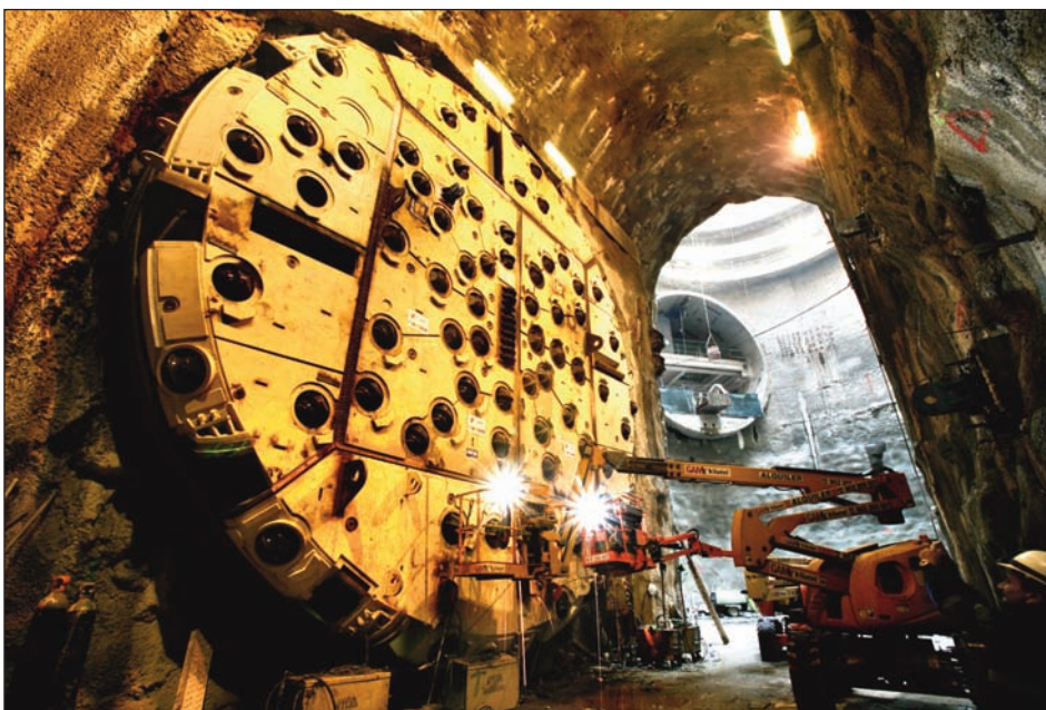
Sustitución de la cabeza de corte de la tuneladora a través de la galería de conexión y extracción al exterior por el pozo de ventilación de Havaneres (Foto: GISA).
