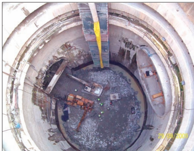
Pozo de ventilación de Plaza Havaneres utilizado para conectar con la traza del túnel y extraer la cabeza de corte a sustituir.
