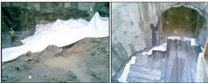
[Fig. 5].- Prevención de proyecciones en voladuras de fondo de pozo: Combinación de barrera geotextil para partículas pequeñas de alta velocidad y complemento con capas pesadas de material de alta resistencia.
